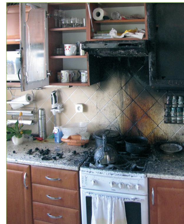
Kuchyně po požáru při vaření bez dozoru.
